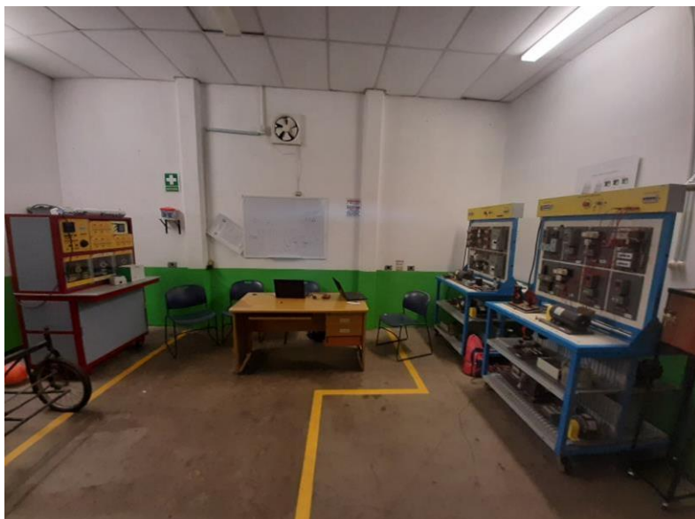
Laboratorio de Maquinas eléctricas
